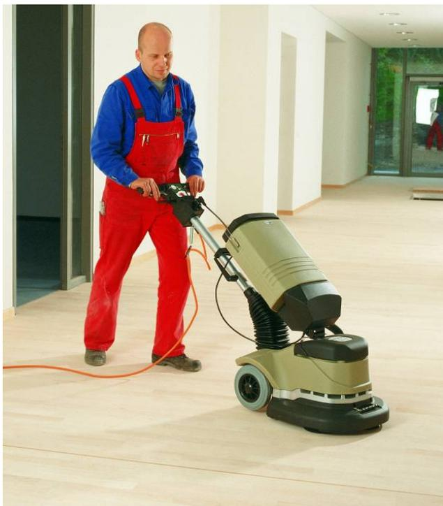
**Warum Schleifen?** \_ In unseren Anleitungen wird oft eine einwandfreie und sauber geschliffene Holzoberfläche vorausgesetzt. Werkseitig geschliffenes Holz, z.B. Mehrschichtparkett oder Massivholzdielen, haben eine hohe Glätte, jedoch kann sich die Oberfläche mit Holzinhaltstoffen und Verunreinigungen durch Verlegung oder Brutätigkeit so zusetzen, dass eine einwandfreie Haftung von Beschichtungen oder das Eindringen von Ölen nicht mehr gewährleistet ist.
