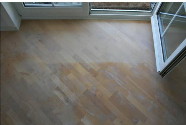
Nachdem die Restfeuchte abgetrocknet war, wurde der Bereich partiell mit Schleifpad schwedenrot praktisch ohne erkennbare Ansätze und Schleifspuren bei- gearbeitet.
