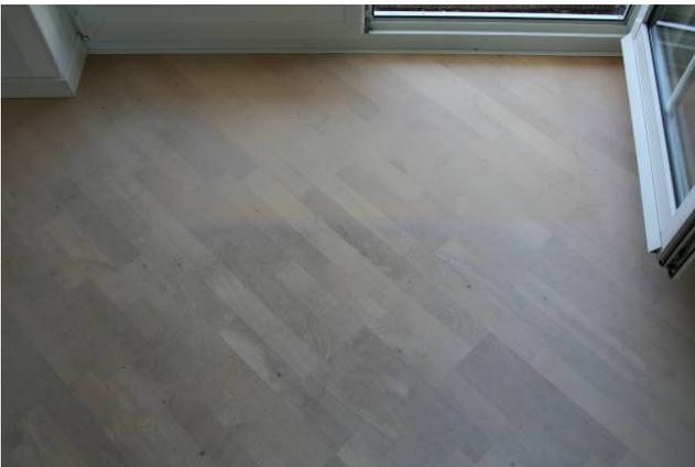
Nach Intensivreinigung und Entgrauung mit Laubholzlauge, noch nicht vollständig getrocknet. Die gelbliche Färbung weist auf Bereiche mit erheblich verschlissener Oberfläche hin.
