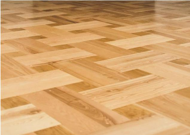
Die Versiegelung mit Lack schützt das Holz gegen eindringenden Schmutz und lässt sich leicht reinigen.
